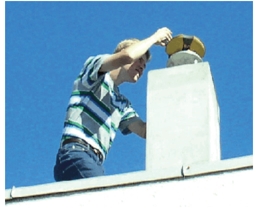
Figur 4. Søyle på Fløy3. Øyvind Grindheim monterer antenne.
